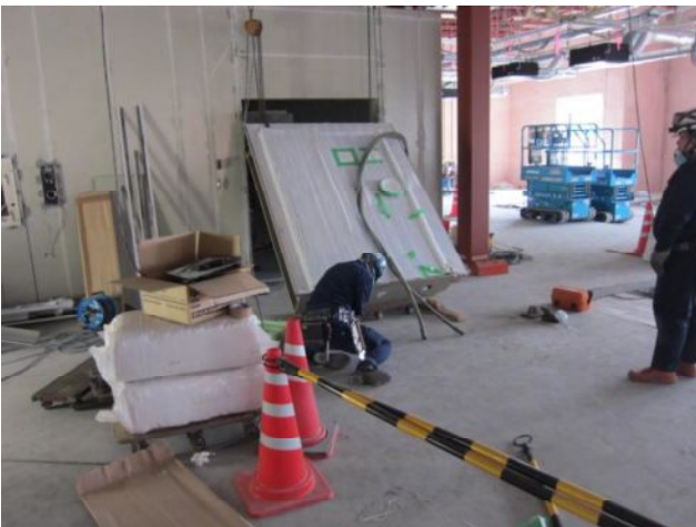
保管庫扉取り付け作業
