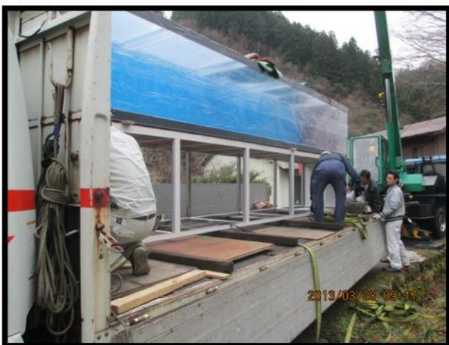
長さ:6m 奥行:1m 高さ:1m 重量:水槽&架台=約800kg
