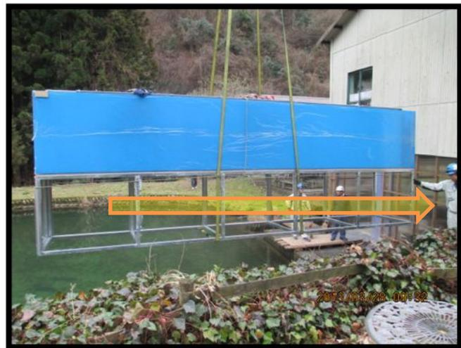
右側建屋との距離に注意しながらの5tトラッククレーンでの作業。足場板でのステージ作成、台車で水槽を受け建屋内へ搬入
