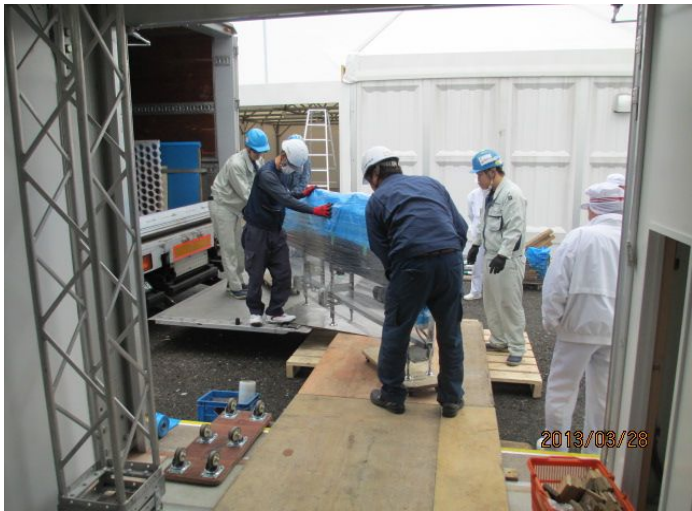
冷却コンベヤー搬入風景
