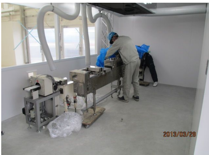
冷却コンベヤー据付風景
