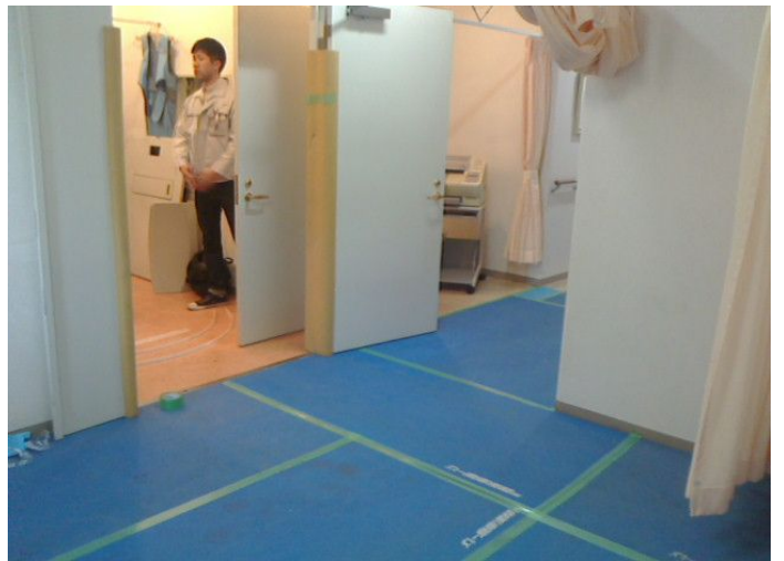
搬入室前の養生
